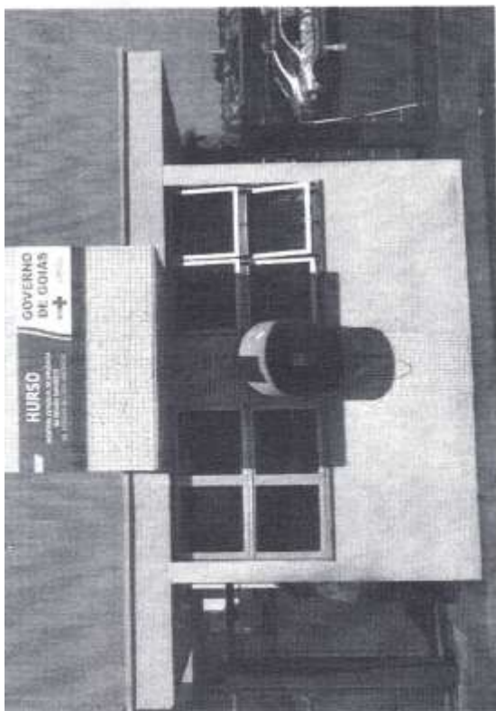
Luminoso em ACM, com legendas vazadas em acrílico e luminoso interno.
